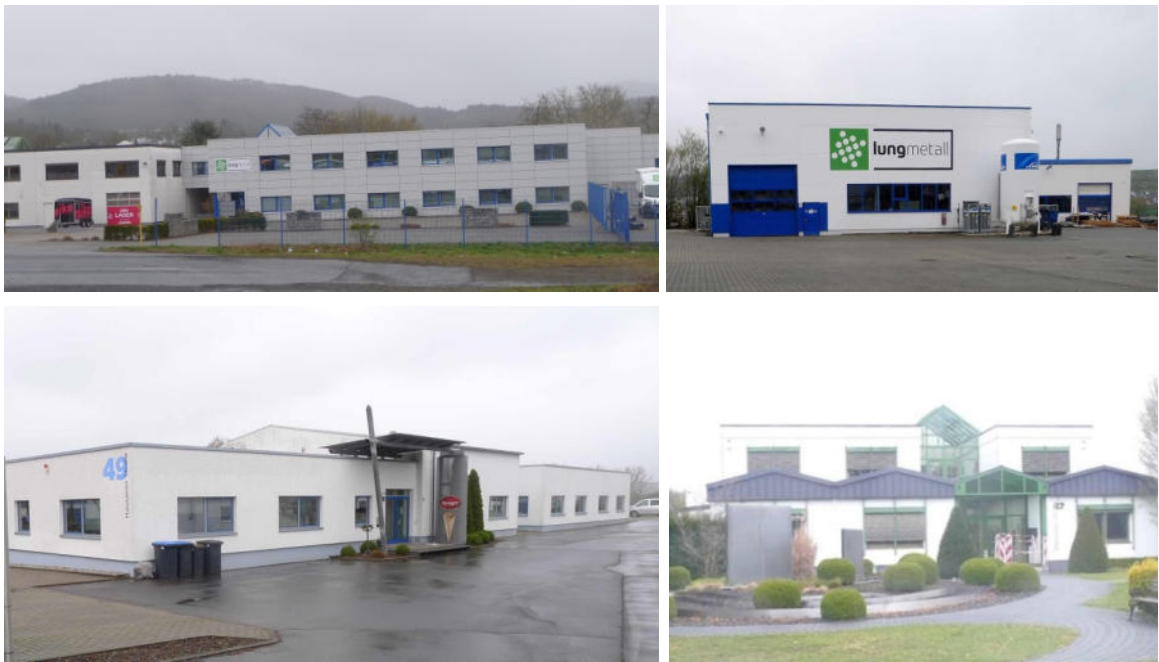
Abbildung 11: Betriebshallen und Büro-/Sozialgebäude
