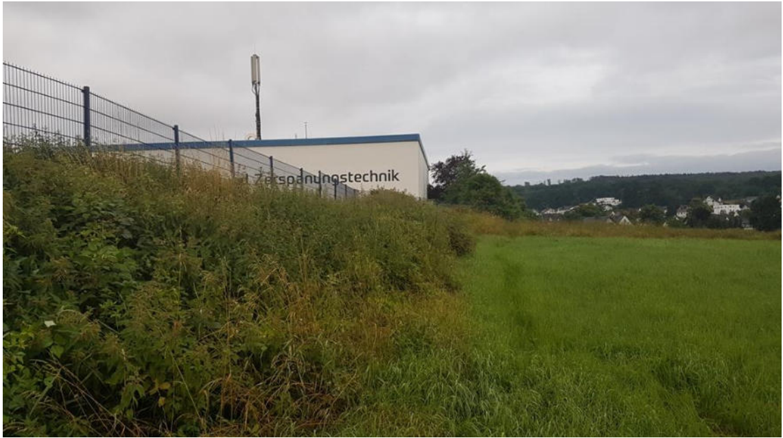
Randstrukturen an der nördlichen Grenze von außen
