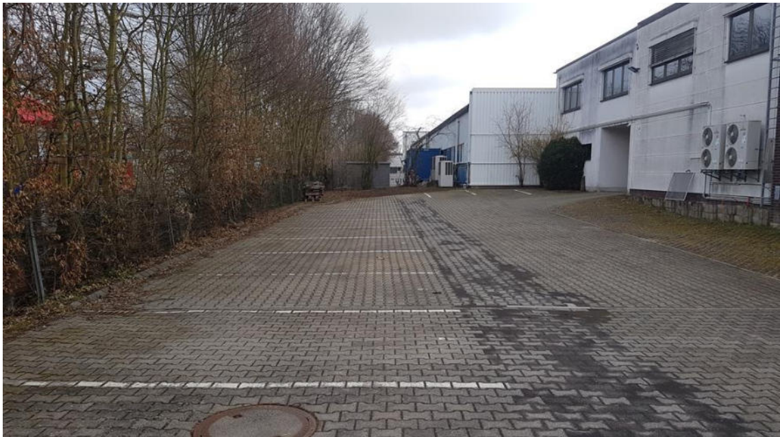
Parkplatz auf der nördlichen Gebäuderückseite
